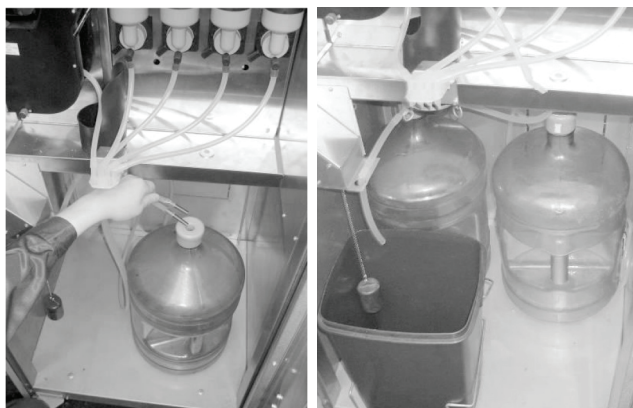
Рисунок 26 - Установка автономного комплекта водоснабжения
